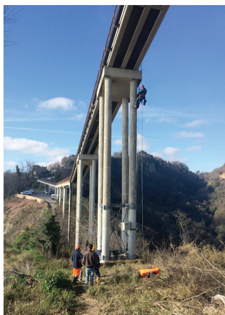
Figura 6 Installazione della centralina di raccolta dati degli strumenti.
