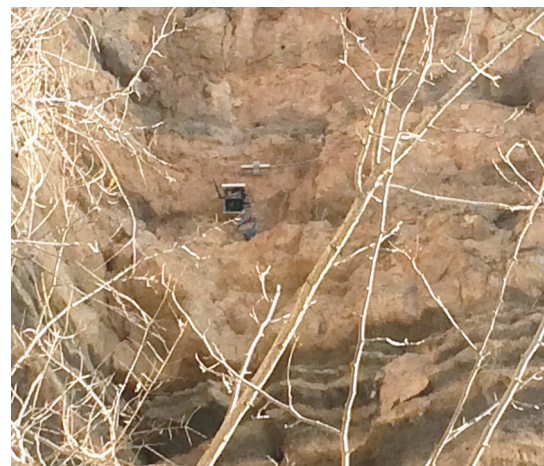
Figura 12 Fessurimetro sull'ammasso roccioso.
