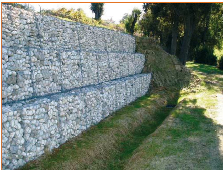
Figura 5. Rete paramassi: intercettano i blocchi di roccia che cadono lungo il pendio. Gabbionate: si usano per movimenti superficiali in terreni, possiedono una certa deformabilità, e permettono il passaggio dell'acqua, evitandone l'accumulo nel terreno alle spalle dell'opera.
